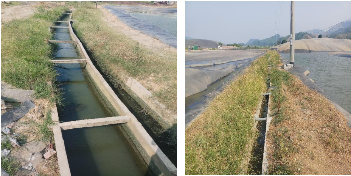
Hình 5: Hệ thống thoát nước thải
