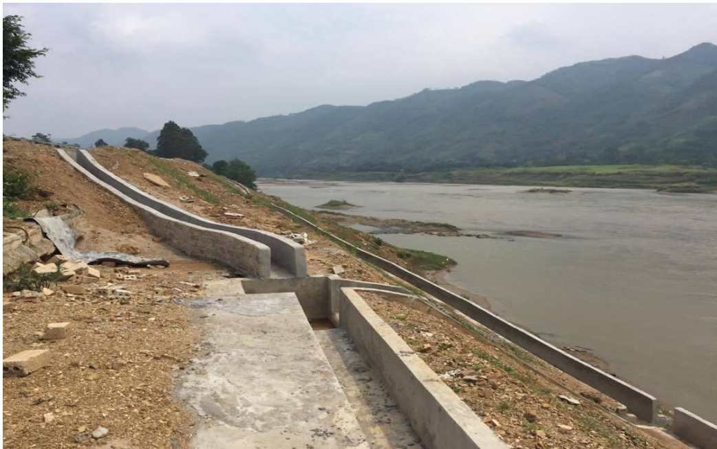
Hình 4: Hệ thống thoát nước mưa
